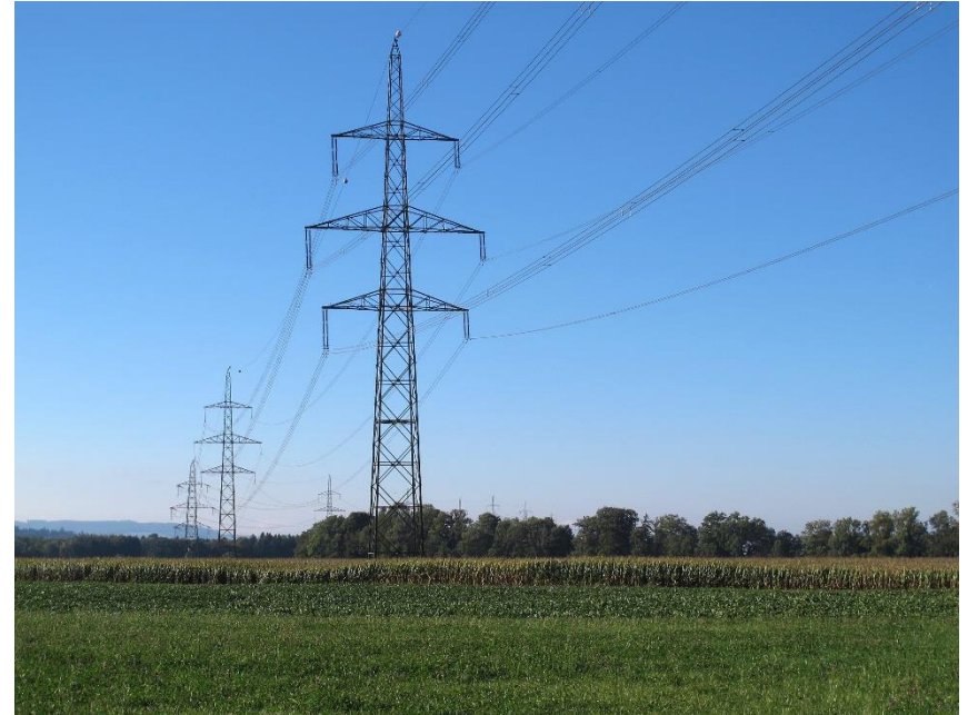
Mastbild nach Einbau Doppeltragkette
